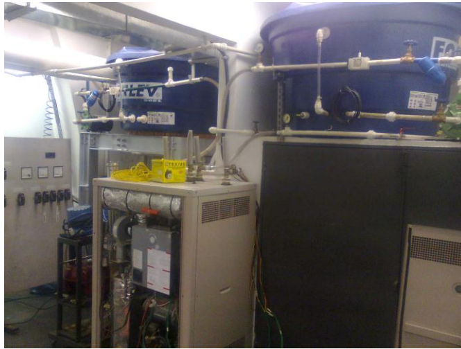
Figura 5 – Esquema de instalação de trigeção.
